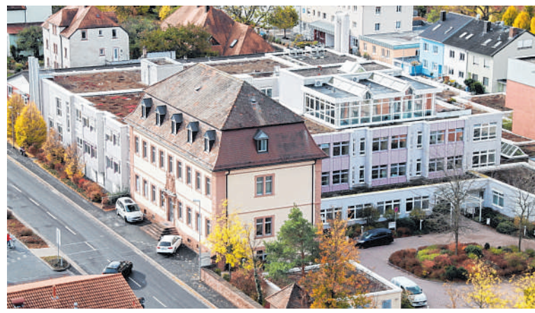
Das ehemalige Krankenhaus Karlstadt gehört nach dem 31. Dezember nicht mehr dem Landkreis. Vorne das alte Distriktkrankenhaus, daran angebaut der neue Teil des Gebäudes.
