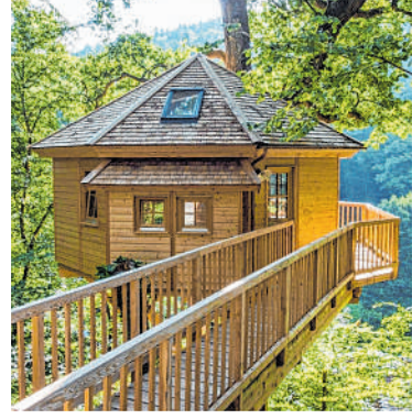
Der Zugang zu dem achteckigen, barrierefreien Baumhaus führt über einen Steg.
